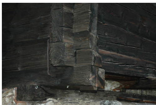
L’angolo di una struttura “a castello” costituito dalle travi squadrate che formano le pareti delle dimore
